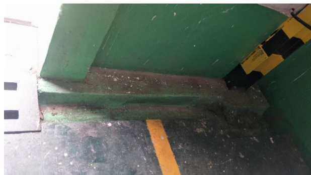
危废库导流沟池
