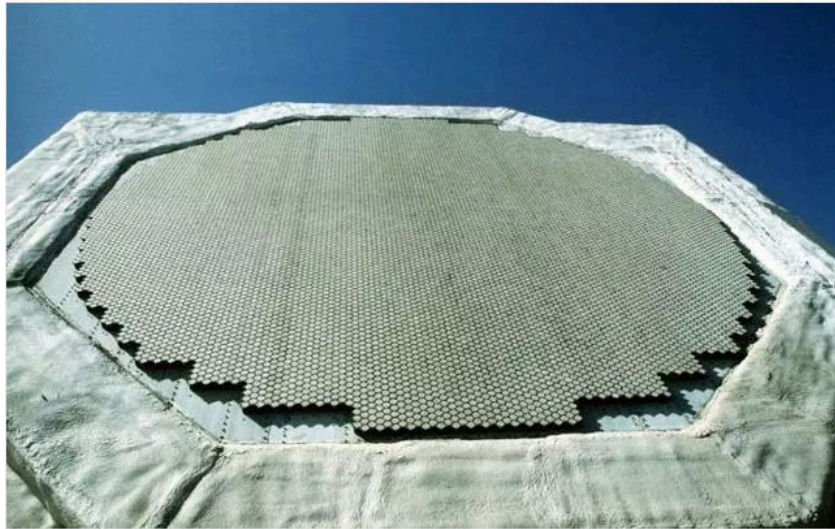
图 2.2 相控阵雷达的天线示意图
