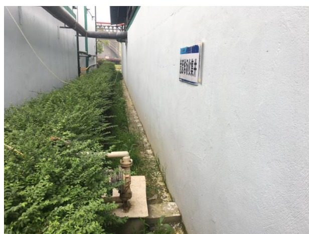
危废库废水收集池
