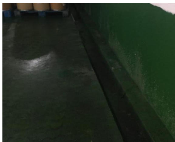
危废库导流沟池
