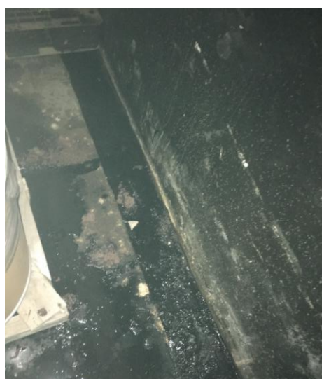
危废库导流沟池
