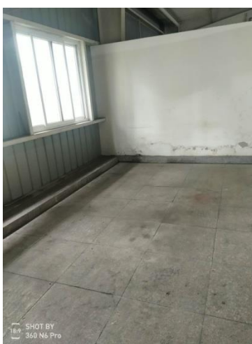
一般固废暂存间内部
