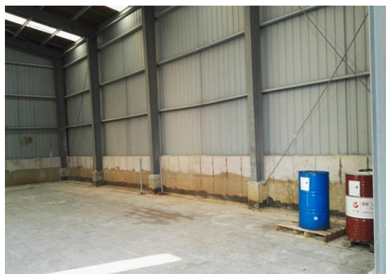
危废暂存场内部
