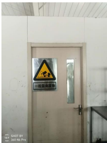
一般固废暂存间
