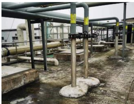
废水处理站废气收集
