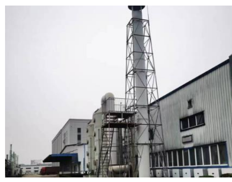
现有制剂车间废气处理装置
