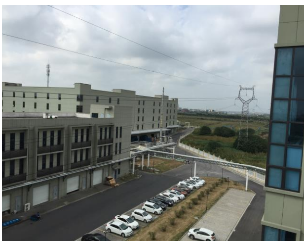
公司厂区西北角一览
