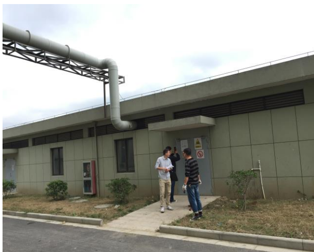
固体废物暂存间
