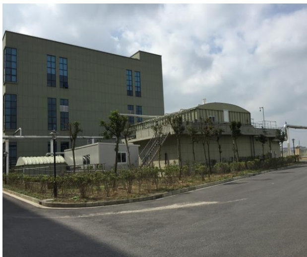
公司废水综合处理站（原有）
