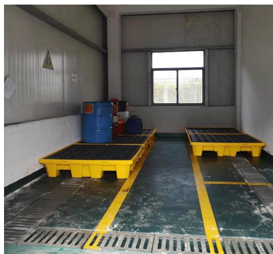
危废仓库内部
