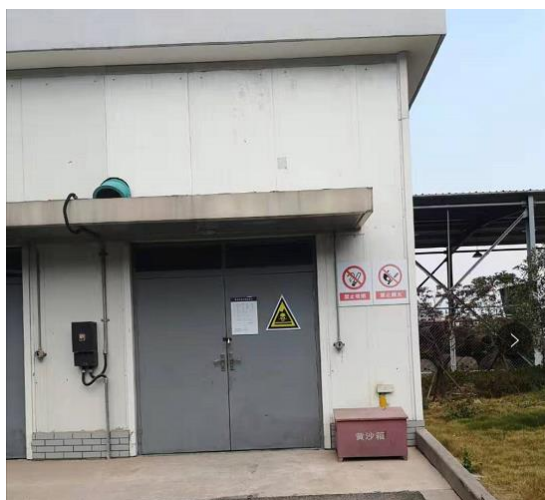
危废仓库外部
