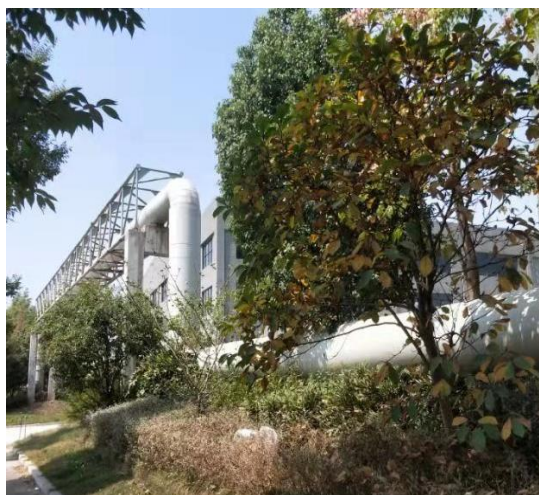
热网 3 号线-通济街主管道
