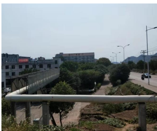
热网 2 号线北端药业主线
